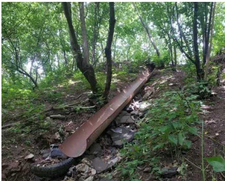
МЕСТА СБРОСА ЛИВНЕВЫХ СТОКОВ С ТЕРРИТОРИИ ГАРАЖНОГО КООПЕРАТИВА НА СКЛОНЫ ОВРАГА
